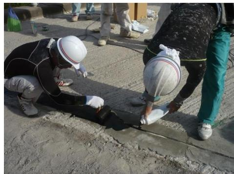
この「AOS 工法」は、リノブリッジ株式会社（本社：東京都新宿区、代表取締役社長 伊藤敦）が開発したシステムで、小規模橋梁の伸縮装置工事と橋面防水工事を一体化して実施する工法です。2017年8月に国土交通省の「NETIS（公共工事等における新技術情報システム）」に登録され、市場で高い評価を受けている特許取得済のこの工法は、従来工法での施工と比較して、小規模橋梁の維持補修工事において工期の短縮とコストダウンを実現しました。
