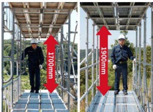
安全性と作業効率向上に、20 cmの差は大きい
