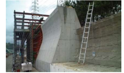
港湾（防潮堤等） 高波、高潮、津波被害を防ぐ 防潮堤の建設工事
