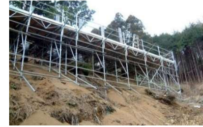
斜面防災工事 地滑り、土砂災害を未然に 防ぐ防災工事等
