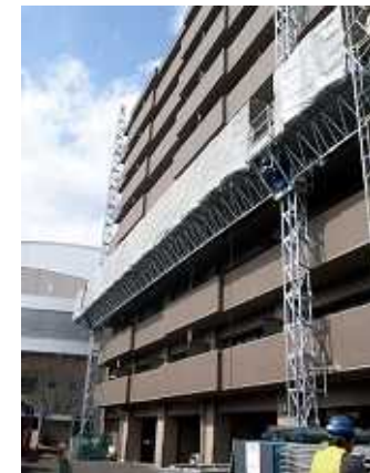
昇降式足場工法 (リフトクライマー工法)
