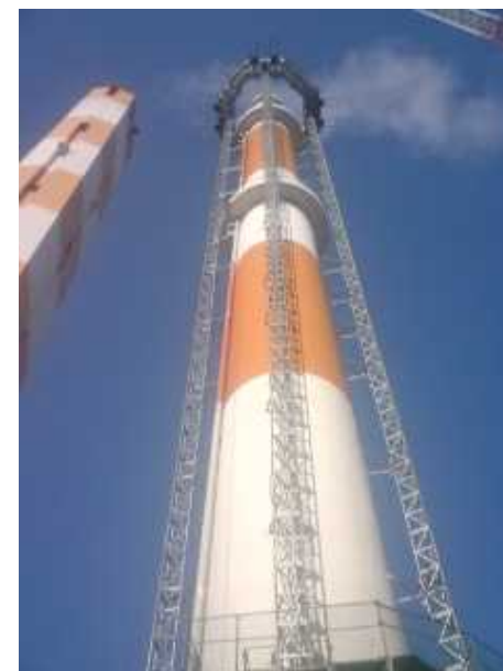
煙突解体工事 (某所)
