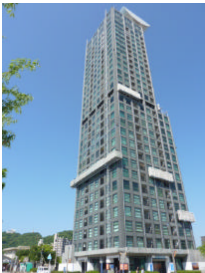
100m以上超高層マンション修繕工事 (福岡県北九州市門司区)
