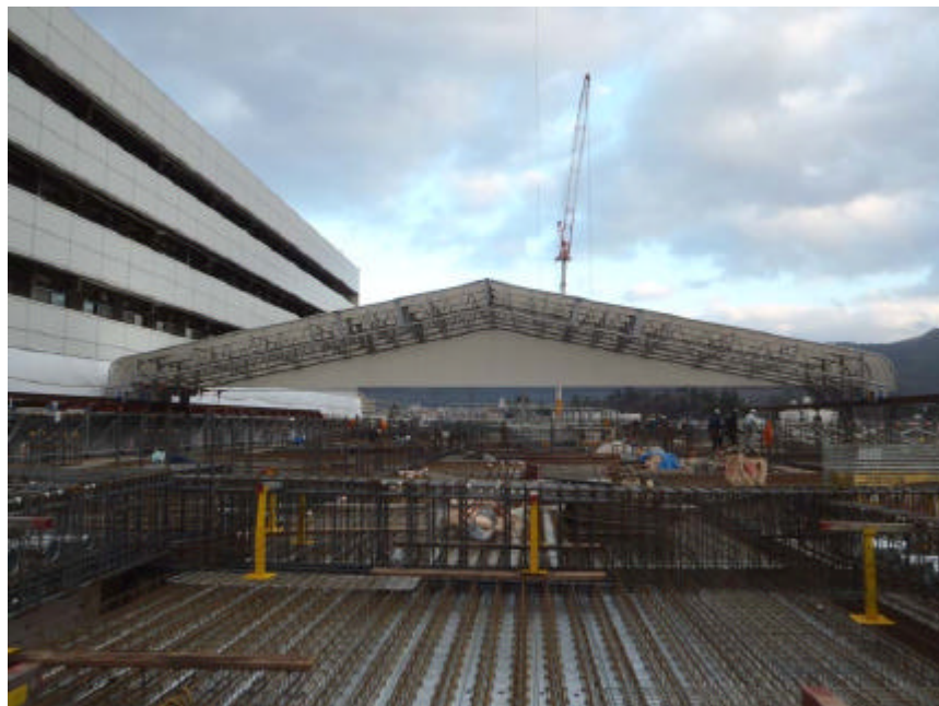
寒冷地における雪養生など急ピッチでの作業に最適 「フリールーフ」
