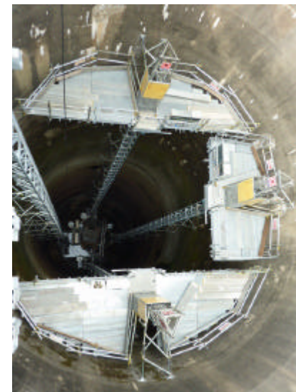
東和発電所 調圧水槽内改修工事 (岩手県 / JPハイテック様 施工)
