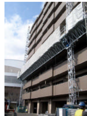
昇降式足場工法 (リフトクライマー工法)
