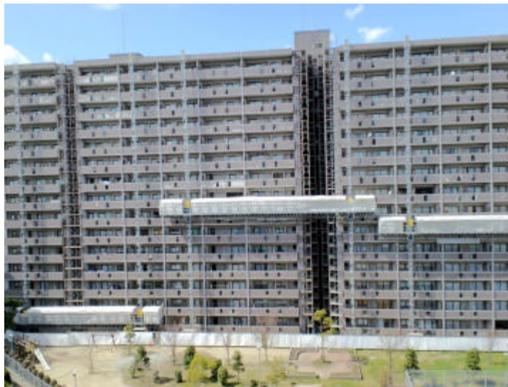
ツインマスト3基を併用したマンション修繕工事 (福岡県)
