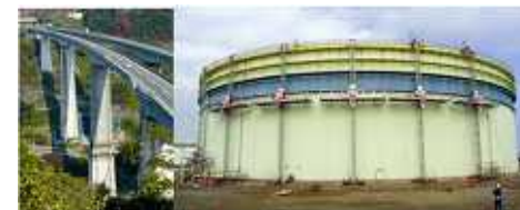
（写真）左：橋梁補修 / 右：火力発電所燃料タンク補修
