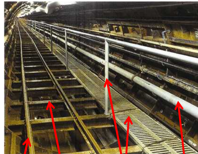
シールド工事 (トンネル坑内)
