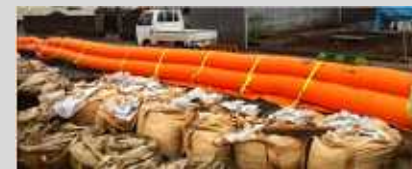
（写真）石巻市高潮浸水対策
