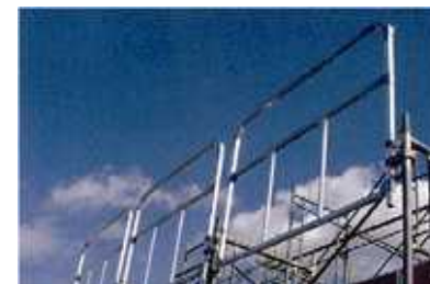
手すり先行足場「ホリーアップ零」
