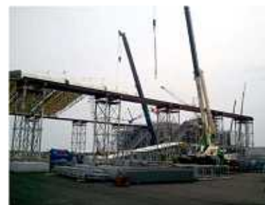
宮城県石巻市 震災ガレキ処理仮設屋根 機材：フリーリールーフ
