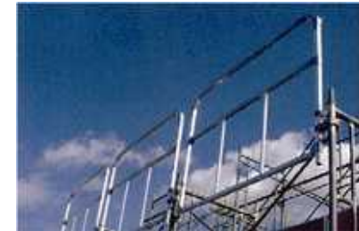
手すり先行足場「ホリーアップ零」
