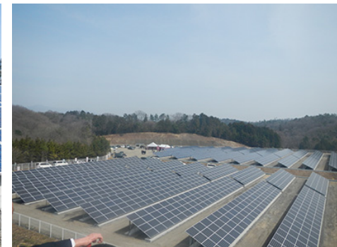
太陽光発電システム
