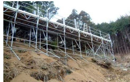
斜面防災工事 地滑り、土砂災害を未然に防ぐ防災工事等
