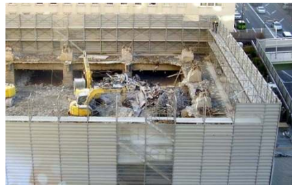
解体工事 立替え、補修にともなう、建造物の解体等
