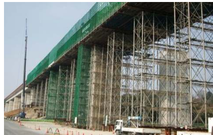
橋梁（新築・維持補修） 高速道路、鉄道、高架橋、橋等
