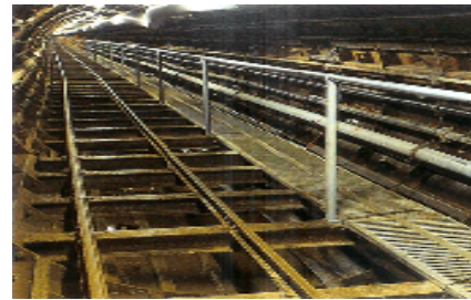
トンネル・地下工事 地下鉄、パイプライン、共同溝などシールド工事
