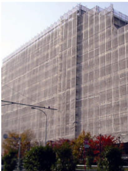
従来工法 (枠組足場 + 養生シート)
