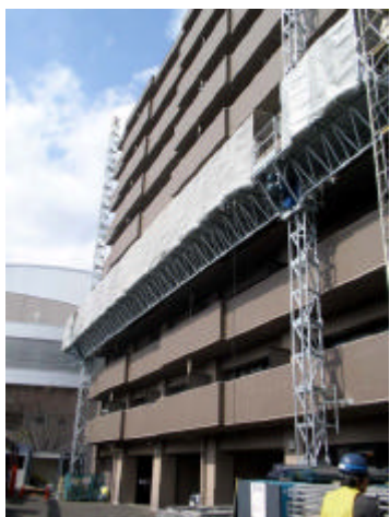
マンション大規模修繕
