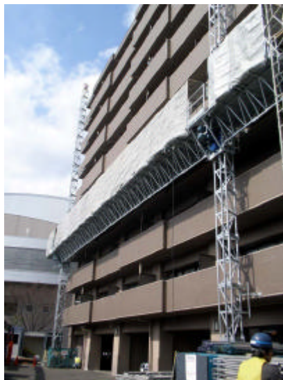
昇降式足場工法 (リフトクライマー)
