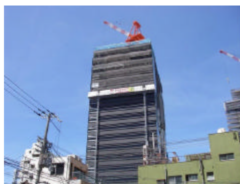
オフィスビル新築
