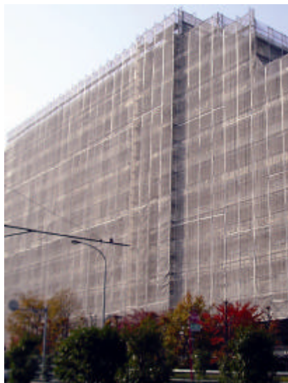
従来工法 (枠組足場 + 養生シート)
