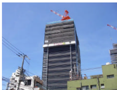
オフィスビル新築
