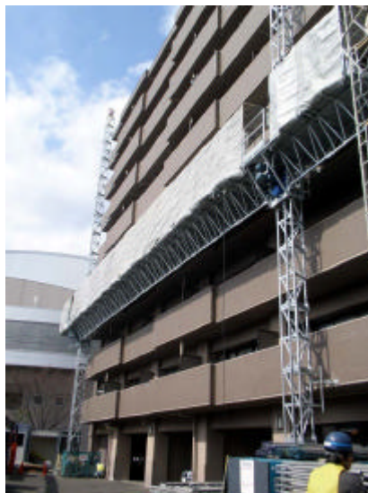
昇降式足場工法 (リフトクライマー)
