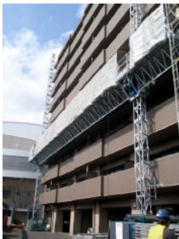
マンション大規模修繕
