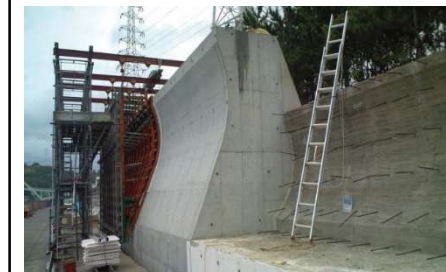
港湾（防潮堤等） 高波、高潮、津波被害を防ぐ防潮堤の建設工事
