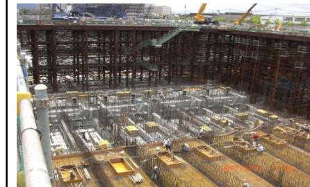
プラント 処理場・焼却炉、プラントの建設・メンテナンス等
