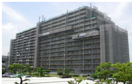
高層建物維持補修工事 超高層建物の維持補修・メンテナンス、解体等
