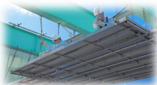
パネル式吊り棚足場 「SPIDER PANEL」
