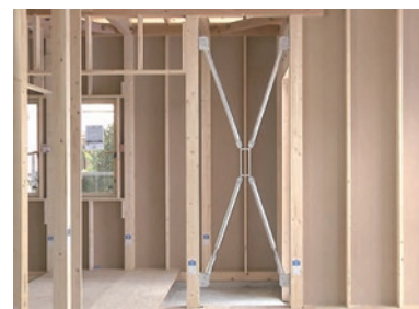
住宅用制振装置「WUTEC」
