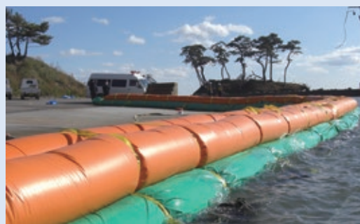
土のうに代わる水のう「タイガーダム」
