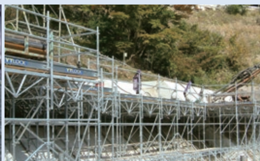
斜面防災工事で活用される「YTロックシステム」
