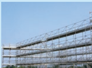
マンションや学校、病院などの建設工事向け作業足場
