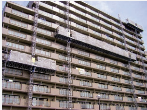
マンション大規模改修工事
