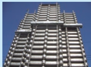
超高層ビルやタワーの改修工事で活躍する移動昇降式足場
