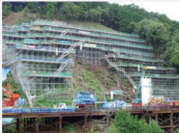
斜面での工事例
