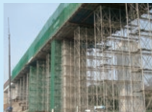
山間部の橋や高架橋などの建設工事における支保工
