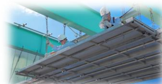
パネル式吊り棚足場 「SPIDER PANEL」
